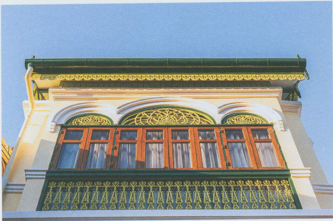
ด้านหน้าของอาคารเป็นกรอบหน้าต่างไม้ที่มีปูนปั้นรูปเส้นวงโค้งเหนือขอบประตู พร้อมช่องลมเป็นงานเหล็กดัดซึ่งสั่งทำขึ้นมาใหม่โดยเฉพาะ
