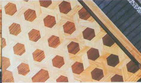
โต๊ะและม้านั่ง "Carpenter" จากแบรนด์ Plato ออกแบบโดยนครเศรษฐ์ สะโบ ประยุกต์การฝังลายลงบนไม้ด้วยเทคนิคอินเลย์ให้เป็นลายจิ๊กซอว์ที่ติดกันแน่นกับการใช้เครื่อง CNC ในการผลิต ให้อย่างคงความสวยงามในระบบการผลิตแบบอุตสาหกรรม
